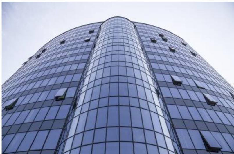
Для реализации высотной части Green Tower используют два типа элементных фасадов. Значительная часть здания сделана с использованием серийной системы элементной сборки Schuco USC 65.HI. Часть основного фасада, которое акцентируется с уникальным рисунком на стекле, выполнена с применением индивидуальной элементной системы со структурным SG- остеклением.
