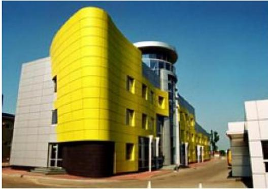
Предусмотренное конструкцией наличие воздушной прослойки обуславливает принципиальное отличие вентилируемой фасадной системы от фасадов других типов. Основное назначение воздушного канала - вентиляция под облицовочного пространства, где обычно бывает слишком тепло и влажно.
