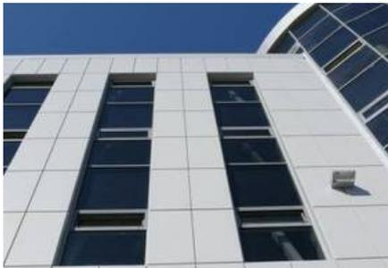
Навесной фасад обеспечивает хороший микроклимат в доме и значительную экономию средств. Его не используют для домов с рельефными стенами и с декоративными архитектурными элементами, а также, когда нужно сохранить исторический вид здания. Вентилируемый фасад - это многослойная стена, у которой внутренний слой из сравнительно тяжелого и крепкого материала (кирпич, бетон) является несущим. На внешней стороне данного слоя крепится теплоизоляция, в основном используют водоотталкивающие материалы.
