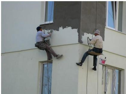
При осуществлении фасадных работ посредством «мокрых» фасадов используется вода (в качестве растворителя), отсюда и название этих фасадов.
